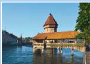
Kappelbrücke, Kanton Luzern
